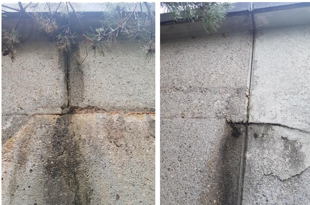
Abbildung 15 Fugen und Risse Wand West
